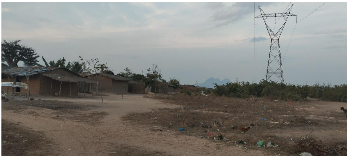
Figura 4-16: Torre 274 dentro de área de Cemitério em Murrupula
