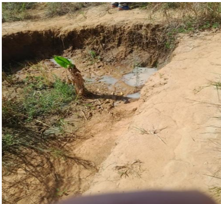
Figura 5-9: Linha de drenagem ao longo da rota do gasoduto opção C (escavada para coletar água)
